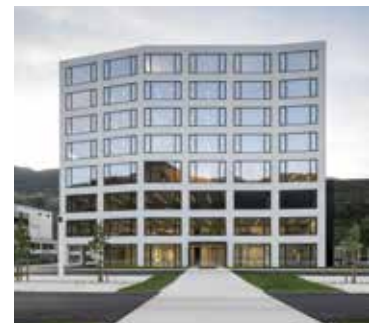
Der Hauptsitz von PROGRESS wurde nach den neuesten wissenschaftlichen Studien zur Arbeitsqualität entworfen und gebaut. Unten links: Thomas Krismer, Senior Consultant Partner, Niederbacher
